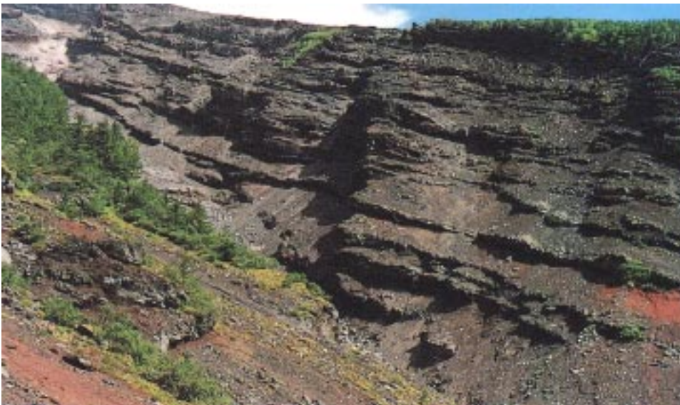
写真5-1 大沢崩れ南斜面（左岸側）
