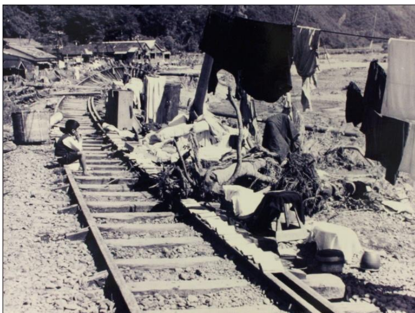
資料2 「駿豆線大仁橋上流の被害」橋本英次氏 提供
