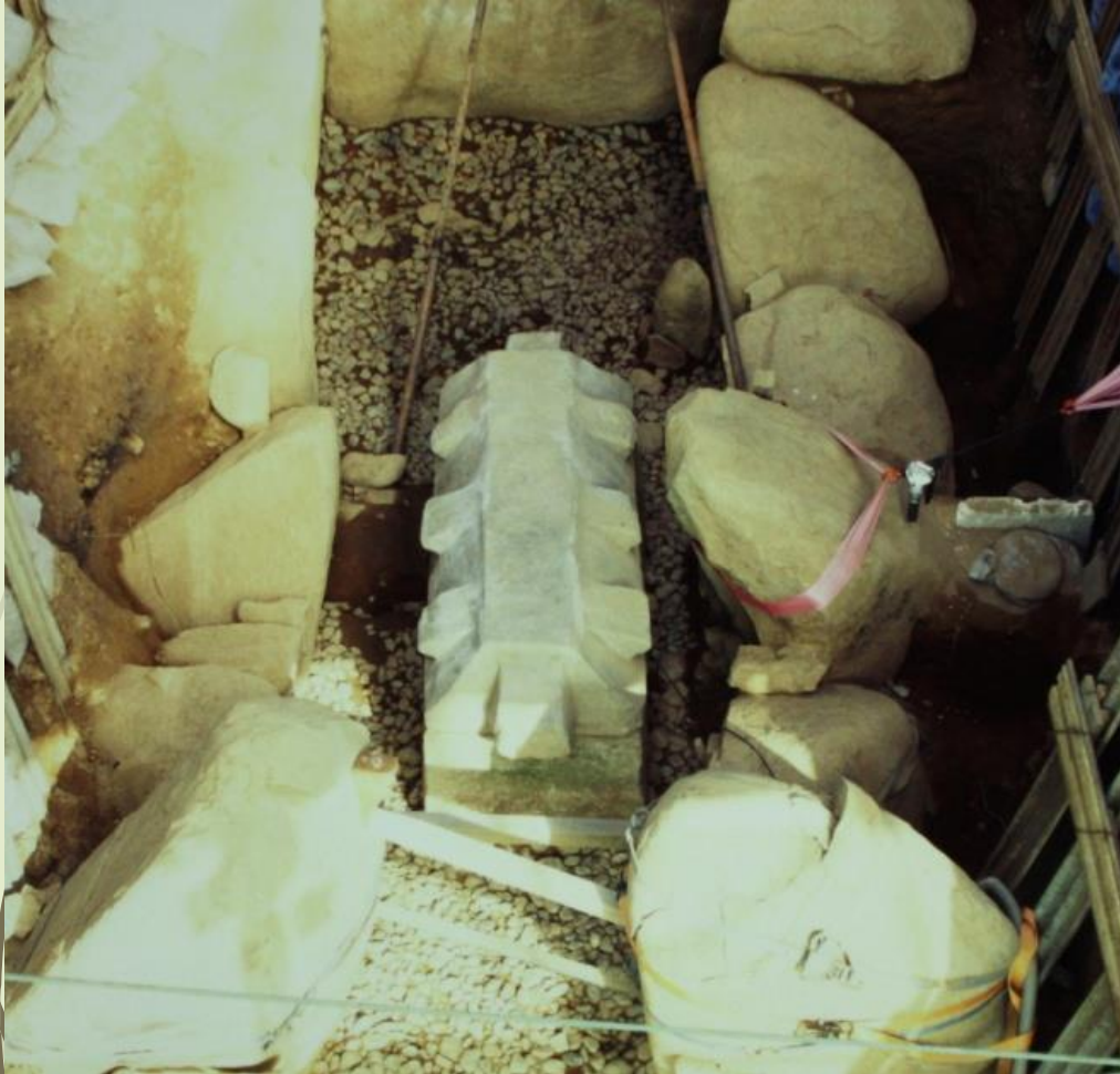
解体作業中の石室内部
